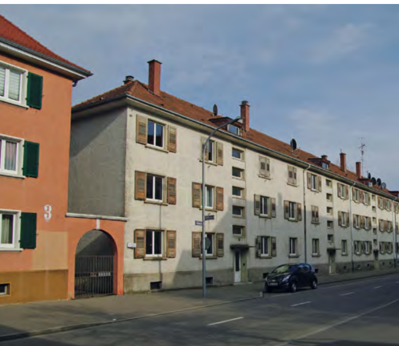
Altes Bestandsgebäude vor dem Abriss.
