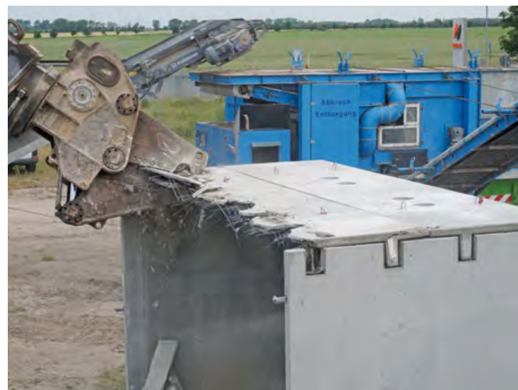
Maschineller Abbruch mit Abbruchzange (Abbruchverfahren Pressschneiden).
