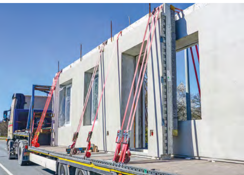
Durch die Vorfertigung lässt sich die Bauzeit reduzieren.
