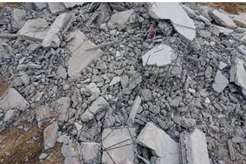
Material aus dem maschinellen Abbruch von Carbonbetonbauteilen.
