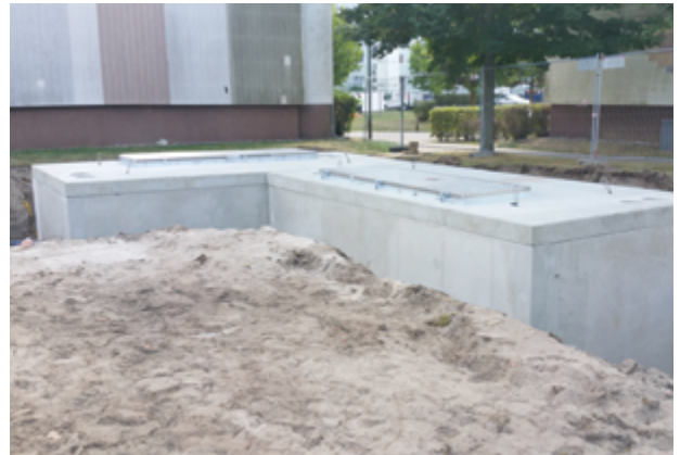
SYSTEMS GROUND CUBE – die Technikzentrale platzsparend unter der Erde.
