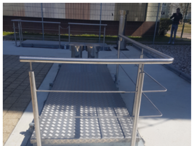
Sicherer Zugang zur Technikzentrale.
