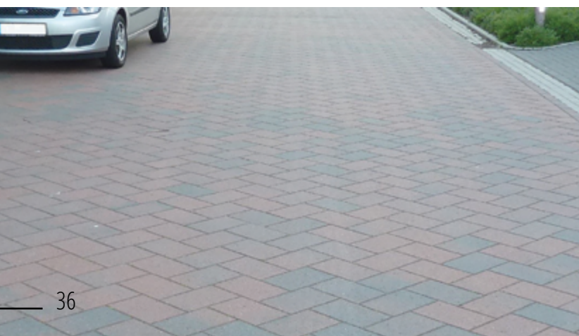
Bild 3: Pflastersteine aus Beton im Fischgrätverband verlegt sind eine gute Voraussetzung für ein lärmarmes Pflaster.
