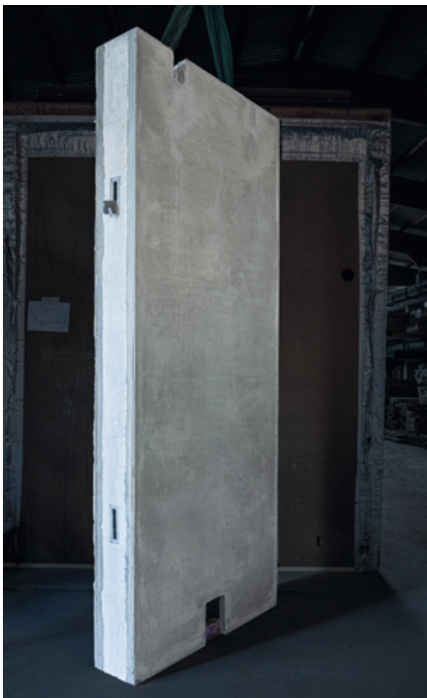
Eine vorgefertigte Wand aus Gradientenbeton.
