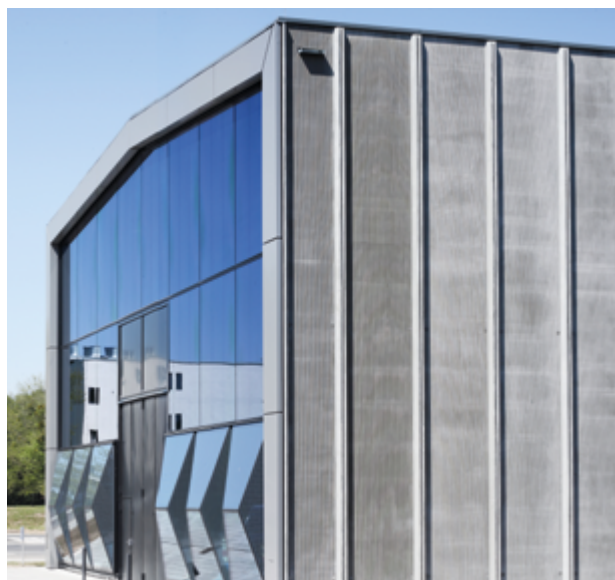
Die Außenhülle der ETA-Fabrik besteht aus 5,5 cm dünnen thermisch aktivierten DUCON-Platten.
