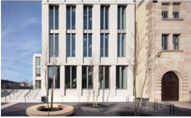
Die moderne Betonfertigteillfassade steht im Kontrast zum natursteinverkleideten Altbau.
